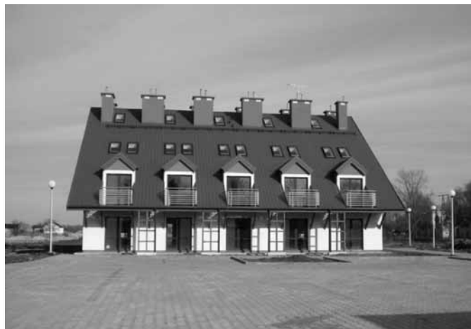
budynek komunalny w Umiasztowie
