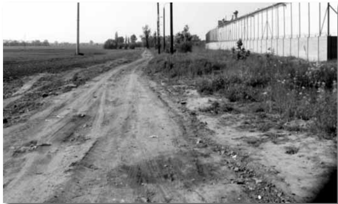
ul. Urocza przed przebudową
