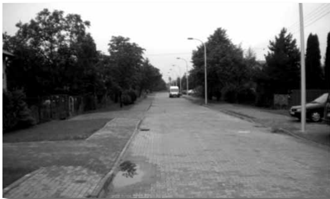
ul. Szeroka po przebudowie
