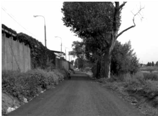
ul. Urocza po przebudowie
