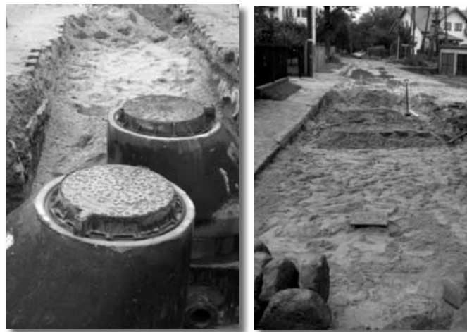
budowa kanalizacji w Wolicy
