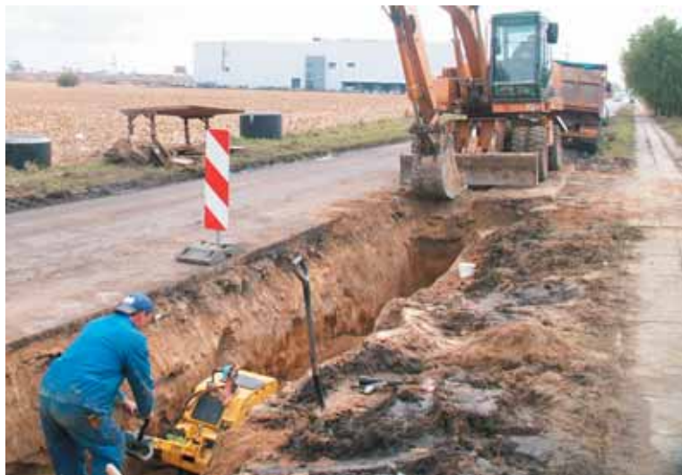
Budowa kanalizacji w Broniszach
