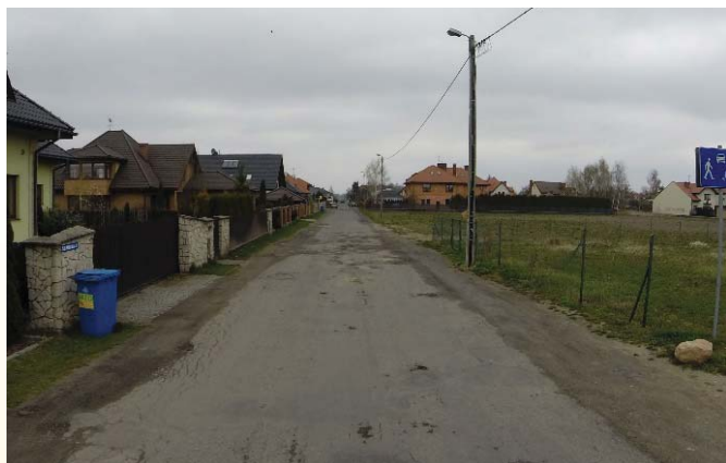
Ulica Szkolna przed przebudową
