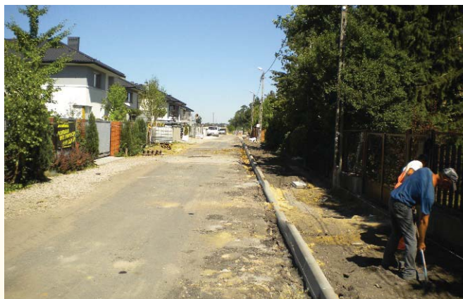
Ulica Szkolna podczas przebudowy
