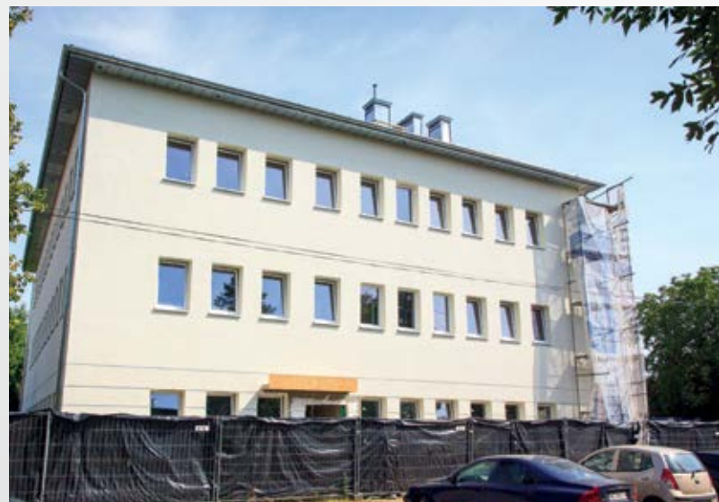
Budowa nowego budynku GSPZLO w Ożarowie Mazowieckim
