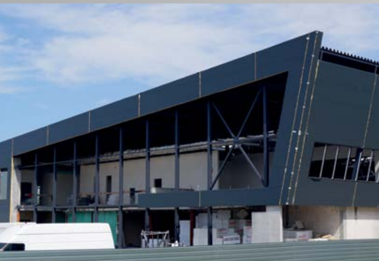
Budowa hali widowiskowo-sportowej w Kręczkach-Kaputach
