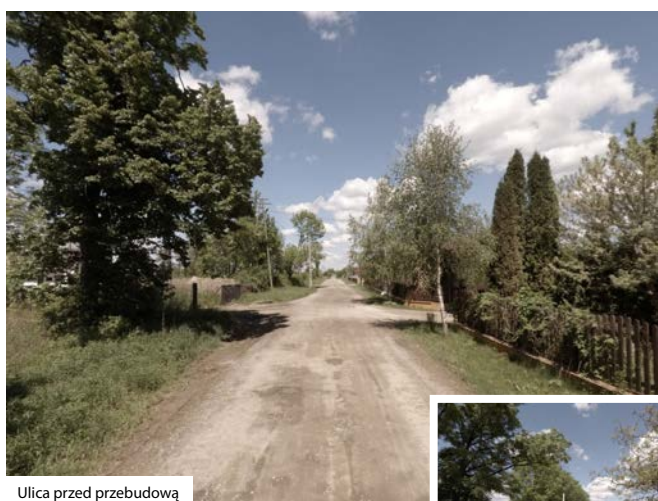
Ulica przed przebudową
