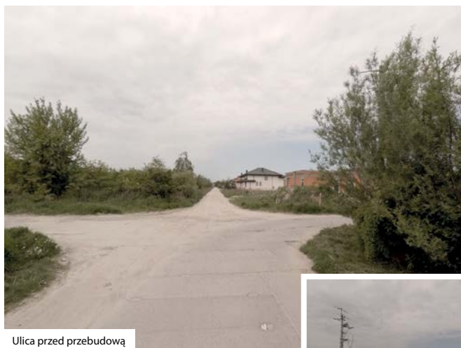
Ulica przed przebudową
